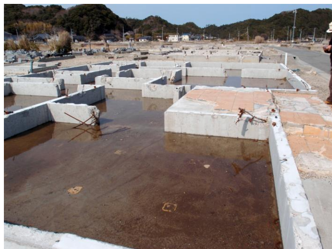
現在のいわき市豊間海岸近傍 津波被害跡
