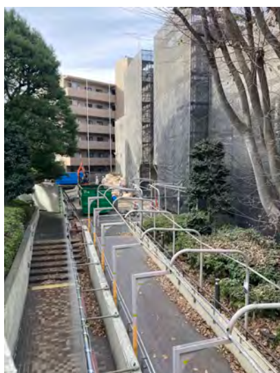
< 改修中の市民センター >
